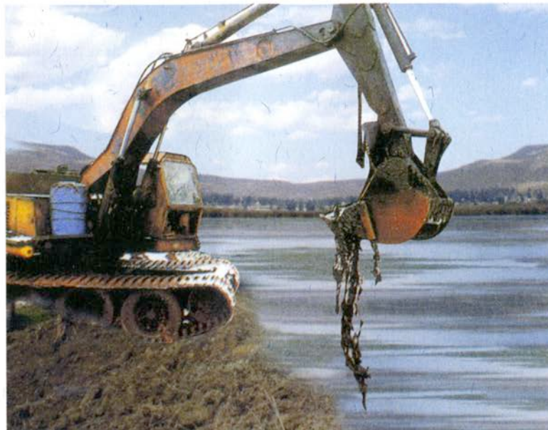
Pala mecánica recoge fangos contaminados en la Laguna Alalay.
