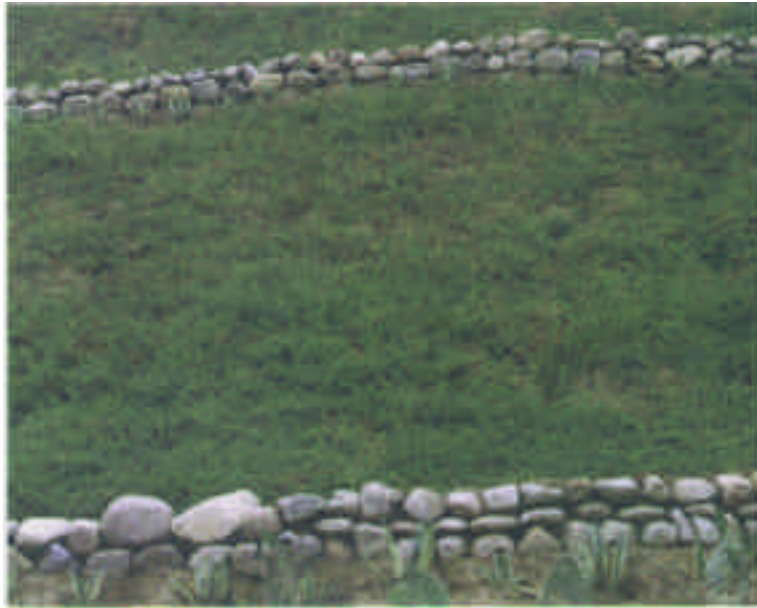
Protección de taludes (presas de tierra)
